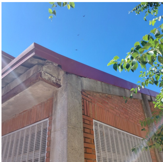
Alero deteriorado edificio principal E-1PL
