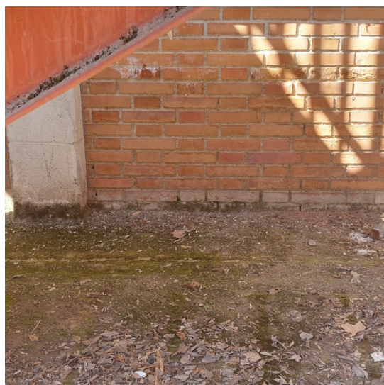
Humedades bajo escalera-metálica Bar
