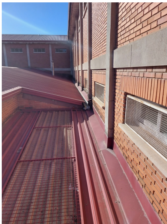
Canalón oculto en cubierta edificio E-1PL
