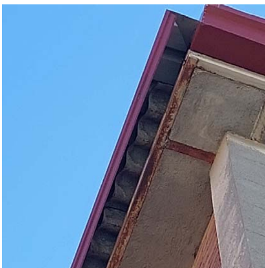
Pefil "L" remate de alero con corrosión
