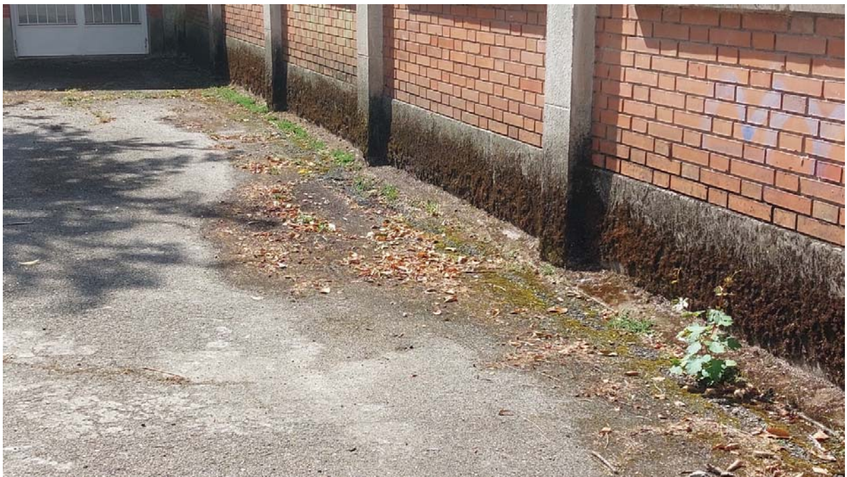
Humedades en fachada Norte EP por salpiqueo del agua
