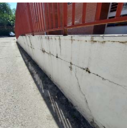
Deficiencias mortero base de rampa
